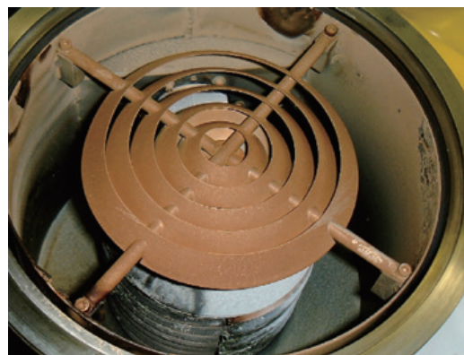
クライオポンプオーバーホール前
